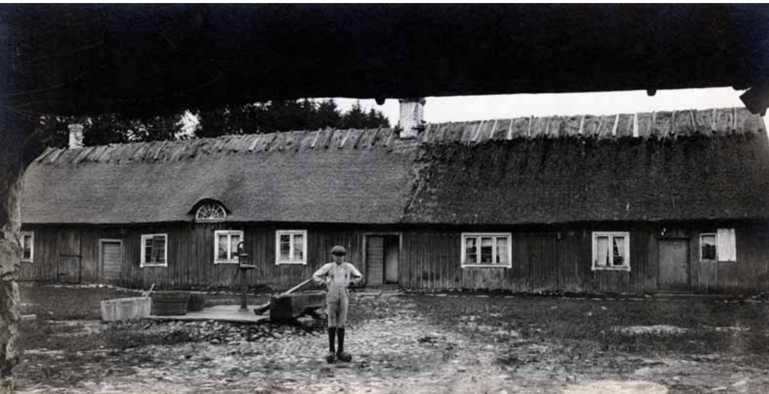
Manbyggnad i Tockarp i Hallaröds socken i Skåne. Foto 1921. Helsingborgs museer (21-350).
