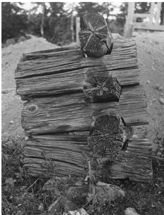
Timmerknut från Gråträsk kapell i Piteå landsförsamling i Norrbotten, fotograferad av John Granlund 1933 och sedan hemförd till Nordiska museet. Nordiska museets arkiv, topografiska bildarkivet (NMA.0064394).
