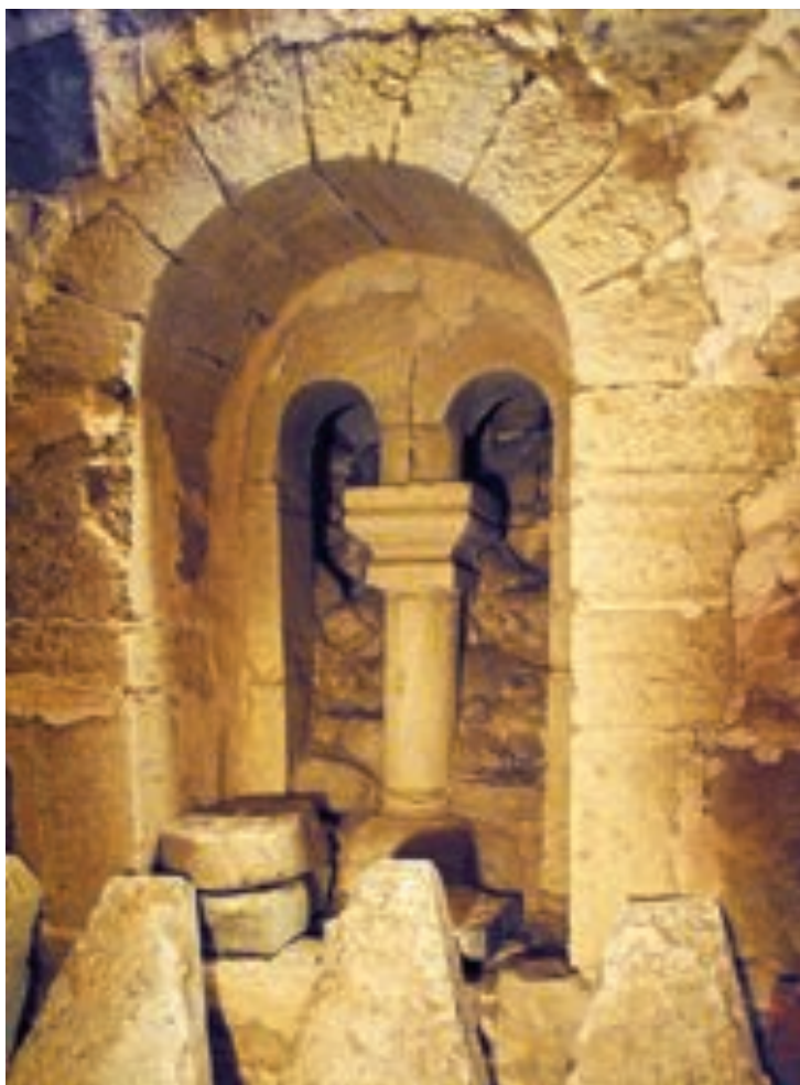
Fig. 9. Simris kyrka. Södra fönsteröppningen. Foto förf. december 2012. —Simris church. South gallery window.
