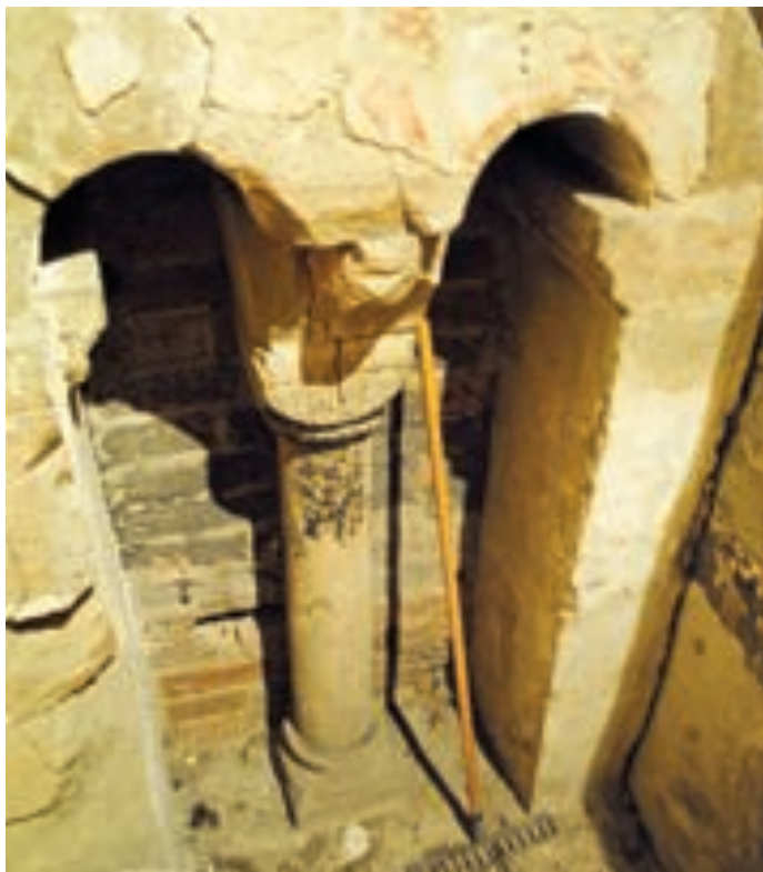
Fig. 3. Mariakyrkan i Vä. Emporens södra fönsteröppning. Foto förf. december 2012. —St Mary's church, Vä. South gallery window.
