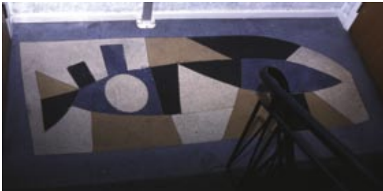
Gjutet golv i terazzo på Vasaloppsvägen, Västertorp (1949)
