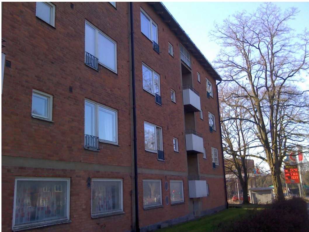
Figur 5: Fasad mot Getingevägen
