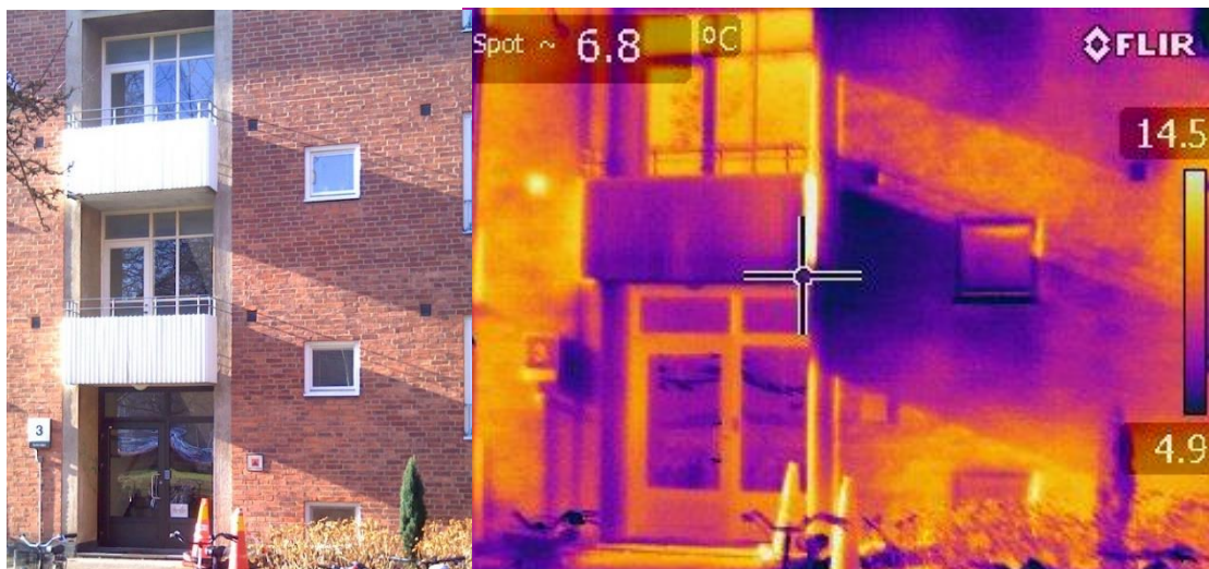
Figur 19: Termografering av trapphus.
