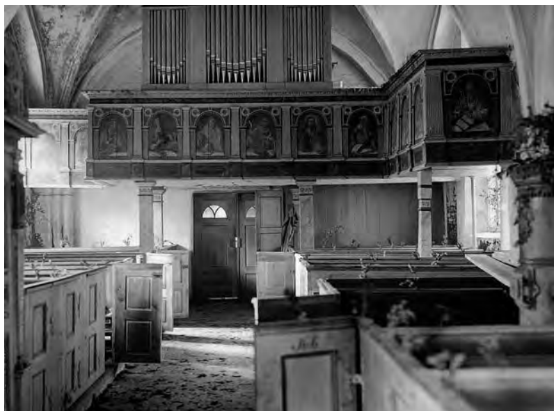
Fig. 16–17. Maglarps gamla kyrka före och efter restaureringen 1970–71. Restaureringen förverkligades genom insamling i församlingen och statliga bidrag förmedlade via Riksantikvarieämbetet. Kyrkans byggnadshistoria klarades genom utgrävningar och murverksundersökningar. Nya golv lade in, med de gamla gravstenarna inplacerade, och den gamla bänkinredningen riktades och återuppsattes. Valvens målade medeltida dekorationer togs fram och den rika inredningen konserverades. Foto före restaureringen i LUHM samt efter restaureringen i ATA.
