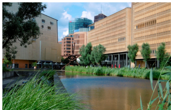
Bild 19. Dammanläggningar vid Potsdammer Platz, Berlin (foto: Jan Henrik Nilsson)
