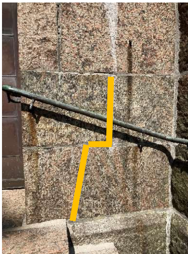
Placering fogbruk 4: våtsläcket Gotlandslime.
