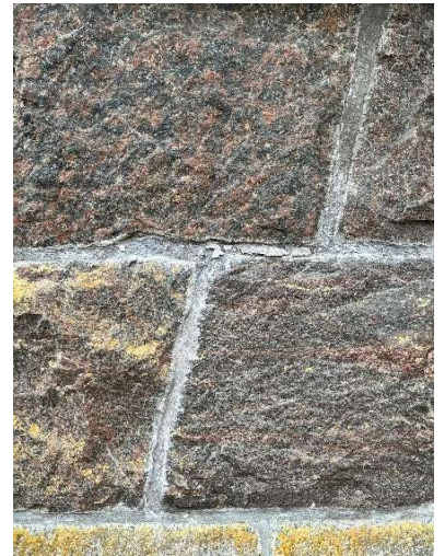
Fogbruk 9, juli 2023. Delvis vittrad. Detta bruk härdade långsamt, vilket noterades vid studieresa i september 2022.
