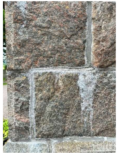
Fogbruk 7, juli 2023. Delvis vittrad. Detta bruk härdade långsamt, vilket noterades vid studieresa i september 2022.
