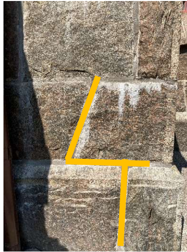
Placering fogbruk 8: hydraulisk Ortokalk.
