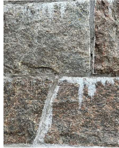
Fogbruk 8, september 2023. Delvis vittrad. Detta bruk härdade långsamt, vilket noterades vid studieresa i september 2022.
