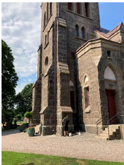
Figur 3.3 Applicering av fogbruk på provytorna.
