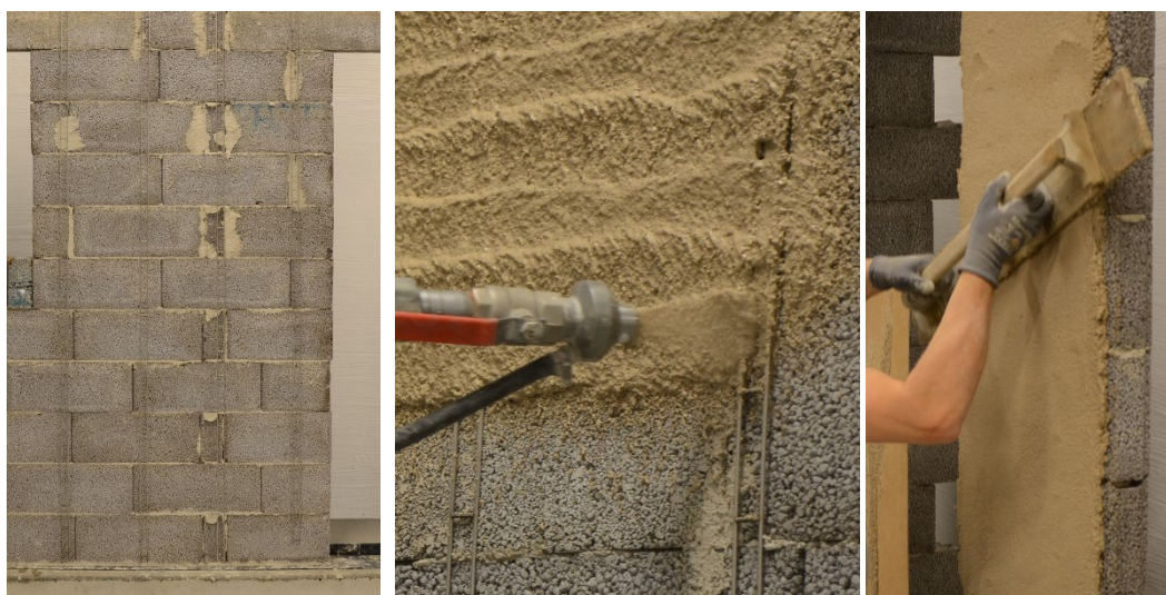
Bild 2.2 Ytförstärkning av vägg. Fixering av bistålet (vänster); sprutning av förstärkningsputsen (mitt); avjämnning av förstärkningsputsen.
