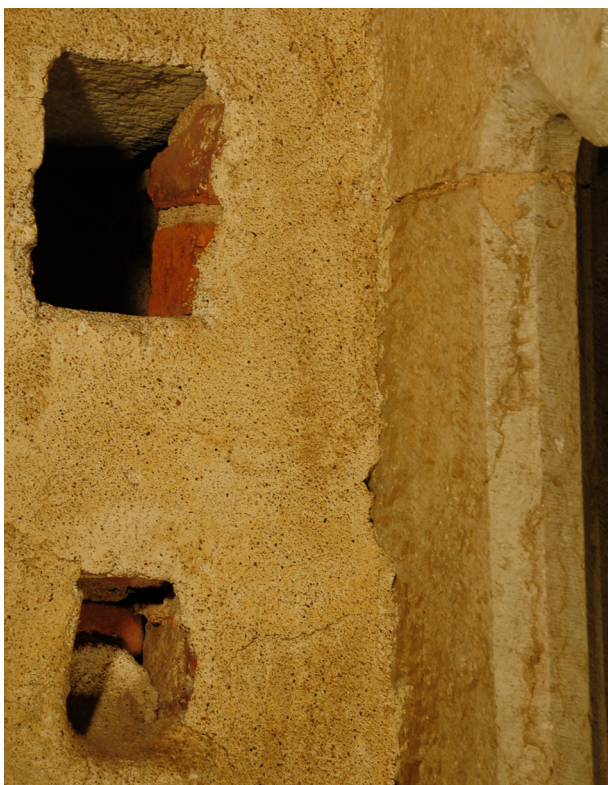
Fig. 9 De två igenmurade rökkanalerna, norr om spisen. Ritning 1Ö2. Foto: Tina Westergren, 2011.
