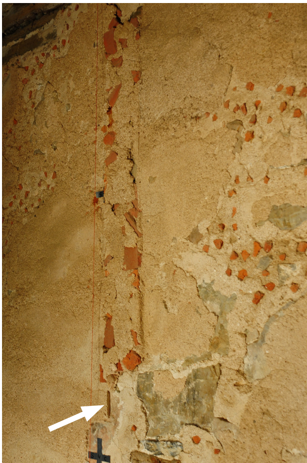
Fig. 8 ett utjämnings-skift (kontext 136) på södra väggen, rum 1. Notera att det saknas puts under utjämnings-skiftet. Pilen markerar en tydlig kant i putsen där den tidigare legat an mot utjämnings-skiftet. Ritning 1S2. Foto: Tina Westergren, 2011.
