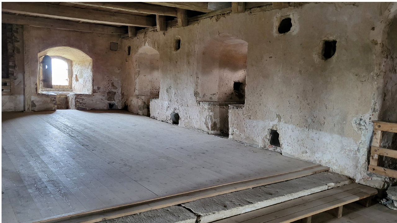
Fig. 12 Rum 2 fotograferat från sydost. Notera nivåskillnaden i golvet, samt de avfasade bockbenen som slutar nedanför murkrönet. På fotot syns också några av de genomgående, fyrkantiga hålen. Foto: Sara Williamsson, 2024.
