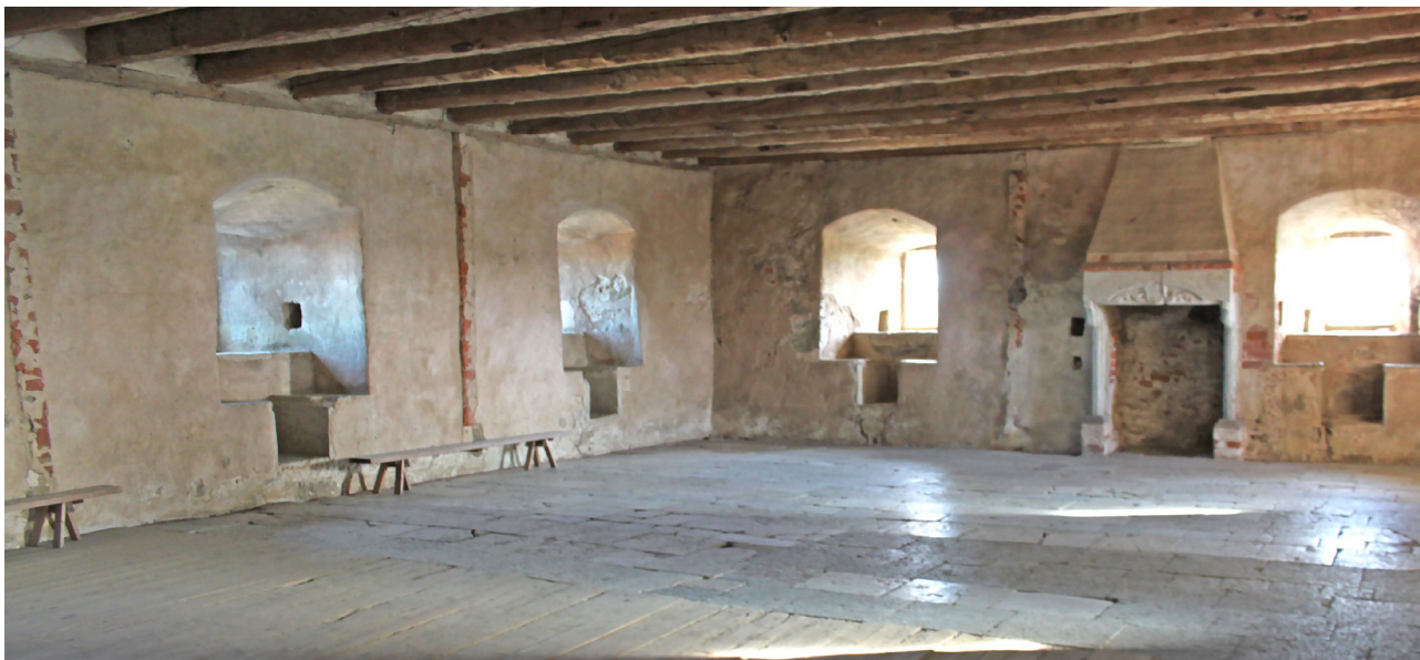
Fig. 6 Rum 1 fotograferat från sydväst. Lägg märke till den öppna spisen som inte är placerad mitt på väggen, utan är förskjuten söderut, samt de lodräta utjämningskiften. Foto: Sara Williamsson, 2011.
