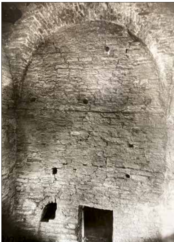
Fig. 7. Vreta klosterkyrka, den södra korarmens västra mur med blottlagd äldre rundbågig öppning, foto mot väster, från restaureringen 1916. Foto: Erik Fant, ATA.
