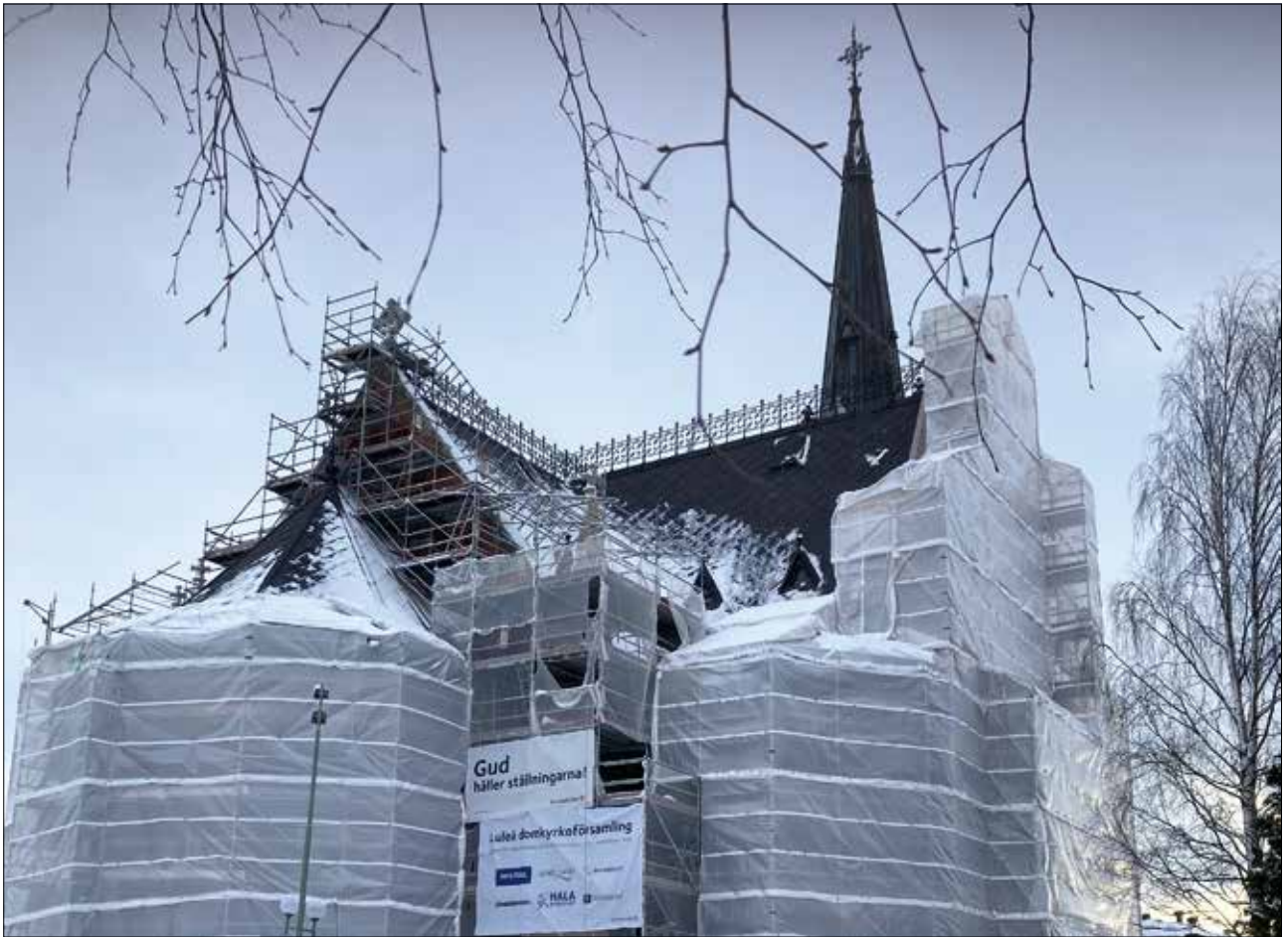
Fig. 2. Luleå nygotiska domkyrka under renovering (mars 2024). "Gud håller ställningarna!" försäkrar ett plakat. Stadsvimlets människor påminns om Guds närvaro även på ett lite humoristiskt sätt. Foto: Thomas Wallerström. © Thomas Wallerström.
