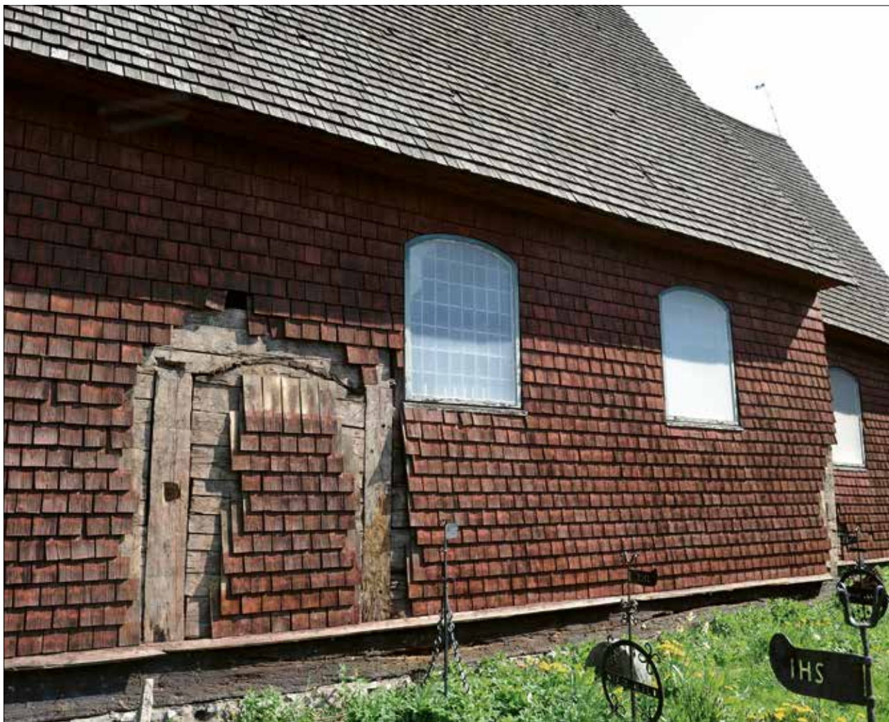
Fig. 3. Byggnadsarkeologisk undersökning av Bosebo kyrka på Kulturen. Den ursprungliga ingången i södra fasaden. Foto: Viveca Ohlsson, 2016.
