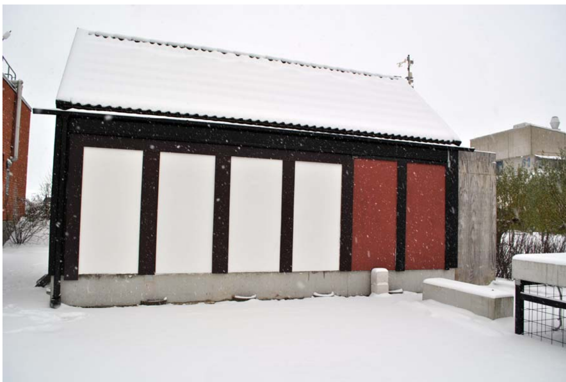
FOTO 1. Provväggarna från utsidan (de vita facken).
