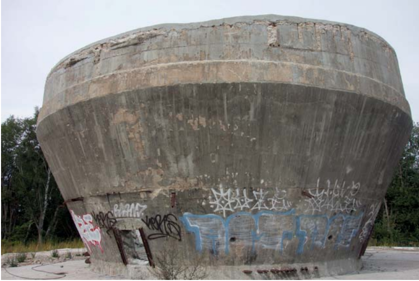
Några meter av nederdelarna till de höga silobyggnaderna har bevarats. Foto: Robert Willim, 2015.
