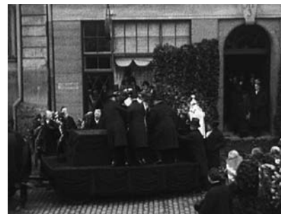
Kistan lyfts upp på katafalken. Den kortväxta Anna Branting skymtar i porten till Nortullsgatan 3.
