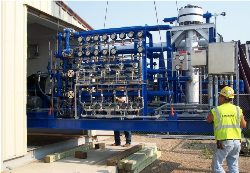
Figur 15. Installation av ammoniakanläggning i Minnesota, USA. Foto: Joel Tallaksen.
