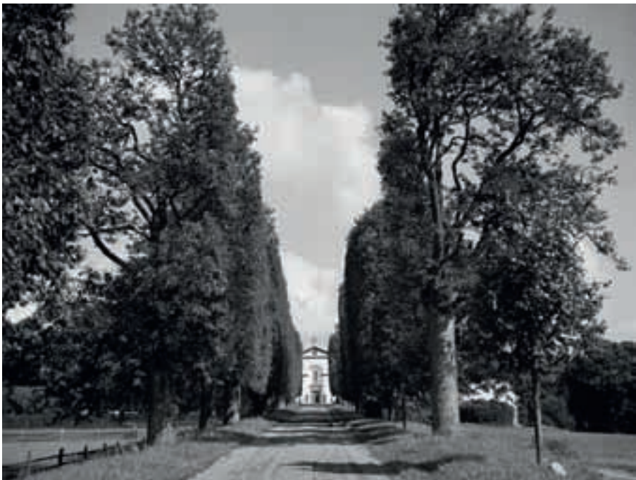
Bild 20. På fotografiet från 1898 kan man se i bakgrunden av bilden att höga träd reser sig mot skyn. Det är alléträden i Stora allén som tillåtits att växa upp. Detta innebär att man sannolikt minst 20 år tidigare upphört med att beskära träden: Källa: Nordiska Museets arkiv, Herrgårdar och boställen, Skåne vol. 31. Övedskloster.
