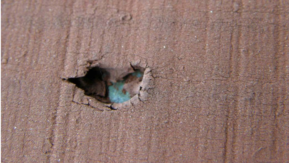
Figur 40 Mycket djupt spikhål med egendomliga skador i färgskiktet
