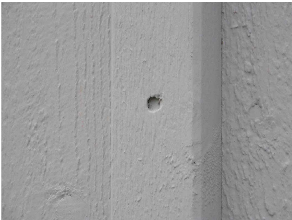
Figur 33 Djupt spikhål där spikskallen ändå fått ett färgskikt.
