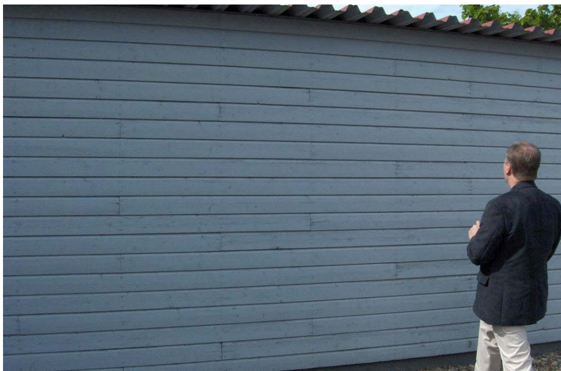
Figur 23 Vertikala spikrader med skarvar på smal läkt eller regel där spiken är så nära paneländarna att dessa spruckit. Skråspikning gör att vissa spikhål syns tydligare.
