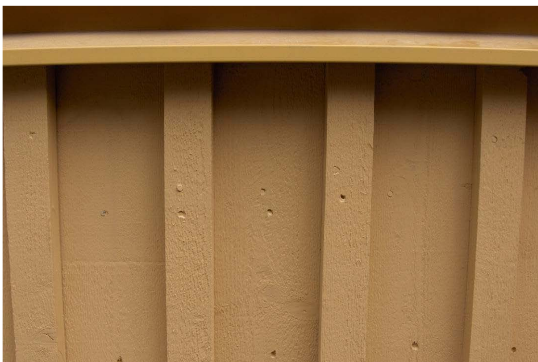
Figur 10 Spikhål som sitter ojämnt i höjdlä och inte alltid centriskt. Några spikar är inslagna exakt i nivå med panelytan medan någon t o m inte är tillräckligt inslagen.
