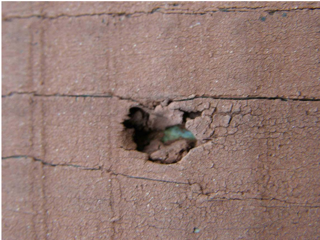
Figur 42 Mycket djupt spikhål med färgrester nere i hålet.
