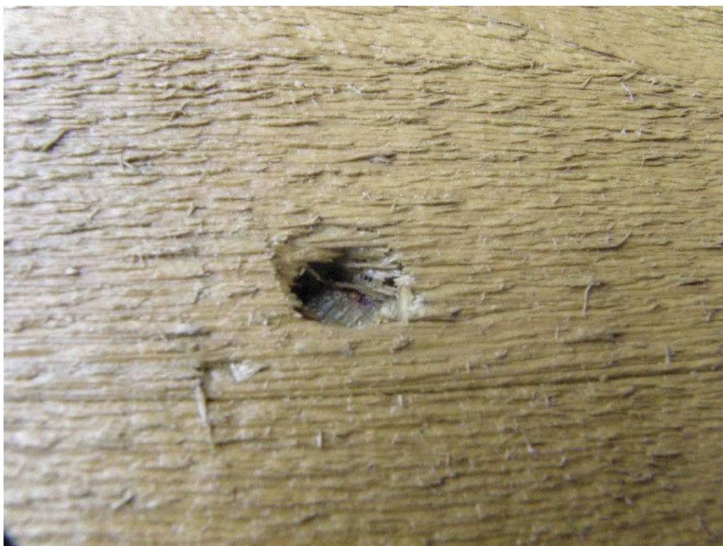
Figur 37 Mycket djupt spikhål med träfibrer delvis täckande hålet.
