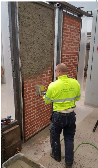
Bild 6. Grundning av testväggen.
