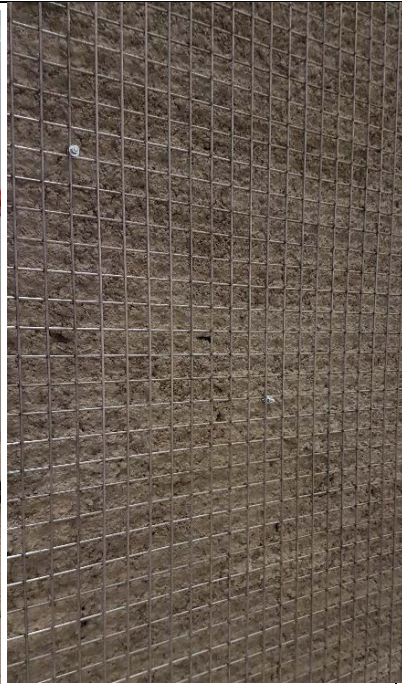
Bild 7. Nätarmeringen är monterad.
