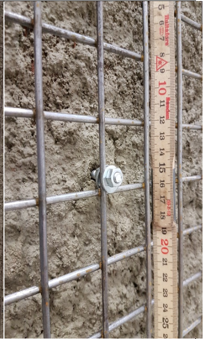
Bild 8. Närbild på nätarmeringens infästning.
