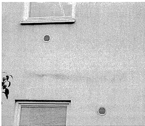
Figur 8.6: Missfärgningar på fasadväggar i kvarteret Ryttern i Stockholm. Efter mikrobiologisk odling av partiklarna på fasaden visade det sig att missfärgningarna i huvudsak är orsakad av mögelsvampen Cladoporium spp., se även Tabell 8.2. Det anmärkningsvärda med missfärgningen som visas i högra bilden är att den ej tycks vara kopplad till fuktbelastningen, vilket annars nästan alltid är fallet.
