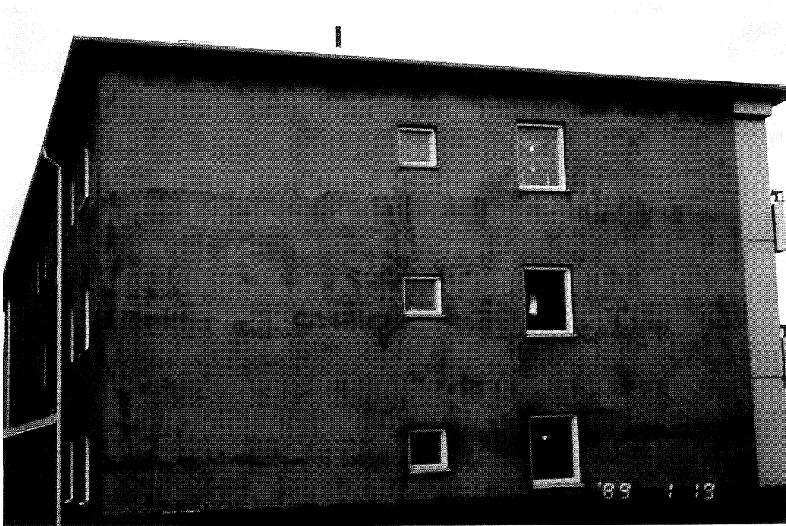
FOTO 18. Fasader med missfärgningar, mot söder och väster.
