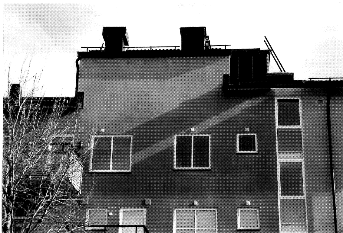
FOTO 2. Missfärgningar upptill (kalkutfällningar) på ny KC-puts.
