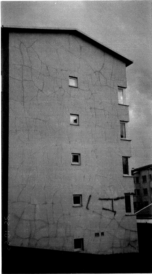
FOTO 3. Urkratsade sprickor på fasad med KC-puts på isolering.
