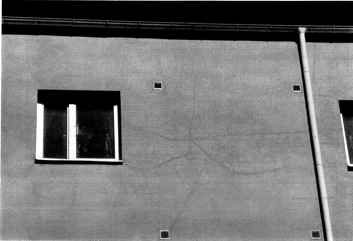
FOTO 5. Stjärnspricka i puts på isolering.
