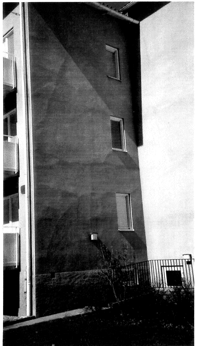
FOTO 4. Sprickor på fasad med puts på isolering.
