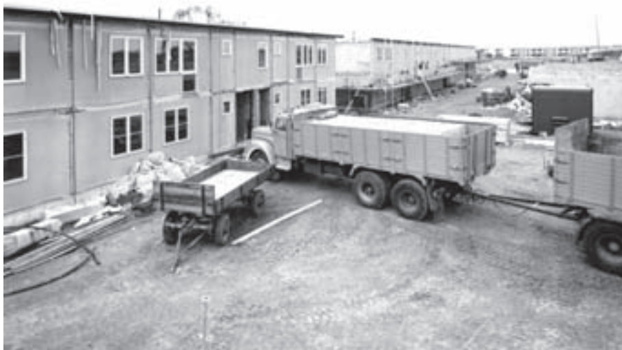
Ett av hyreshusen på Dalhem under uppförande. Flaket på lastbilen är full med det gula teglet som skall muras på huset. Fotografi från AB Hälsingborgsbild, tillhandahålllet från Tommy Ebersjö, Helsingborgshem.
