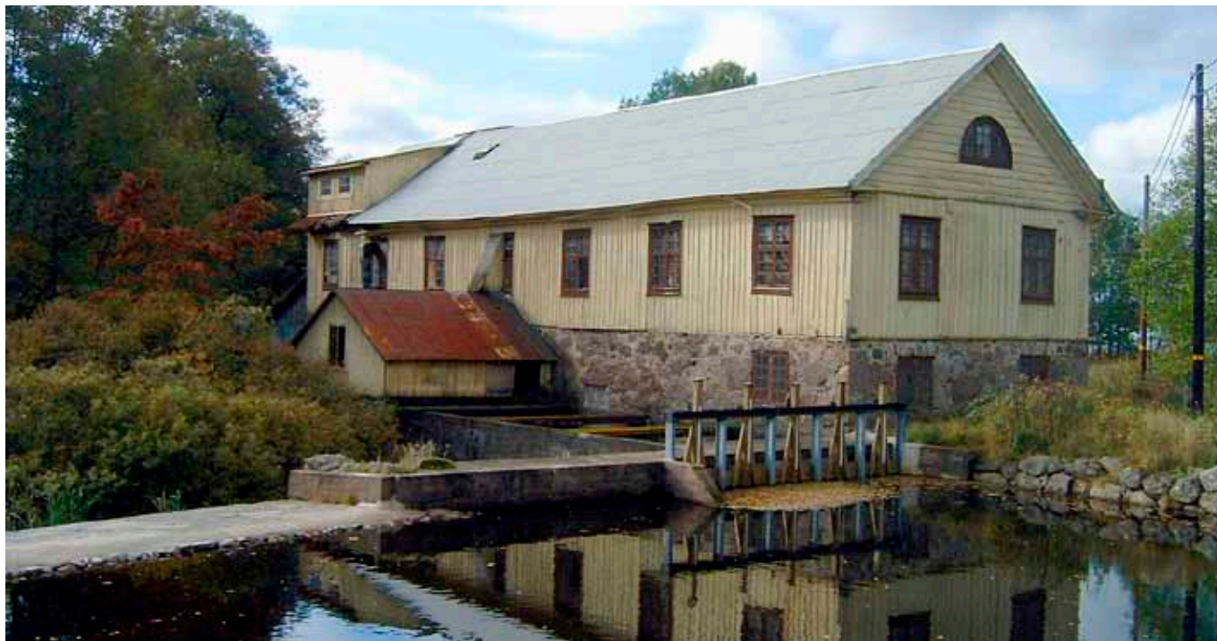
Örsleds kvarn före restaureringen 2008.
