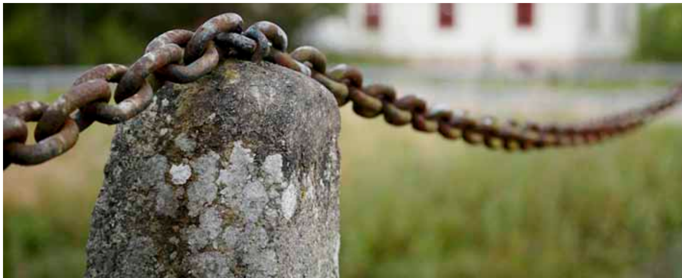
Detalj av broräcket vid stenvälsbron vid Örsled.
