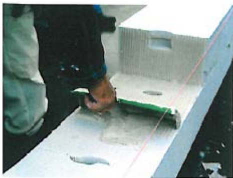
Bild 2.5, t.v. tunnfogslimning av homogena lättbetongblock och Bild 2.6, t.h., kompositblock med två skikt lättbetong och mellanliggande isolering.
