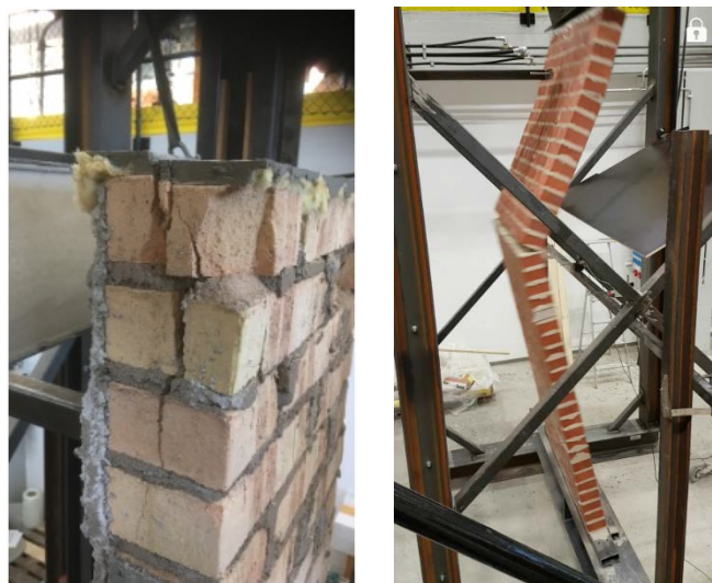
Bild 9.1. Vänster – lokalt brott i excentriskt belastad vägg; höger – knäckning av tegelvägg (Källor – M. Molnár respektive J. Jönsson, LTH Konstruktionsteknik).
